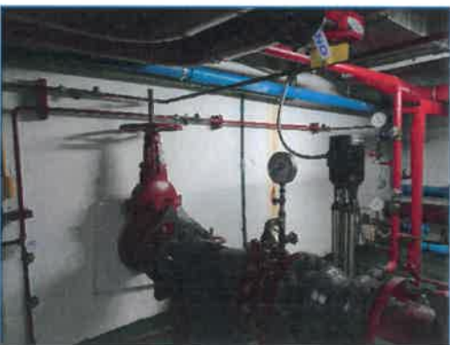
ภาพถ่ายที่ 2.2-20 ระบบแจ้งเตือนอัคคีภัยและป้องกันอัคคีภัยภายในโรงแรม
